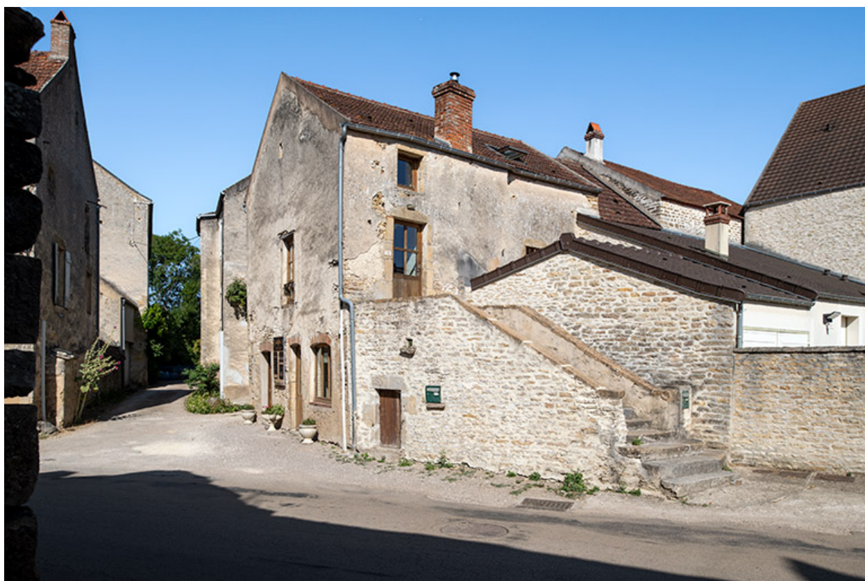
L'ensemble de la maison vue de la rue de la Mairie.
