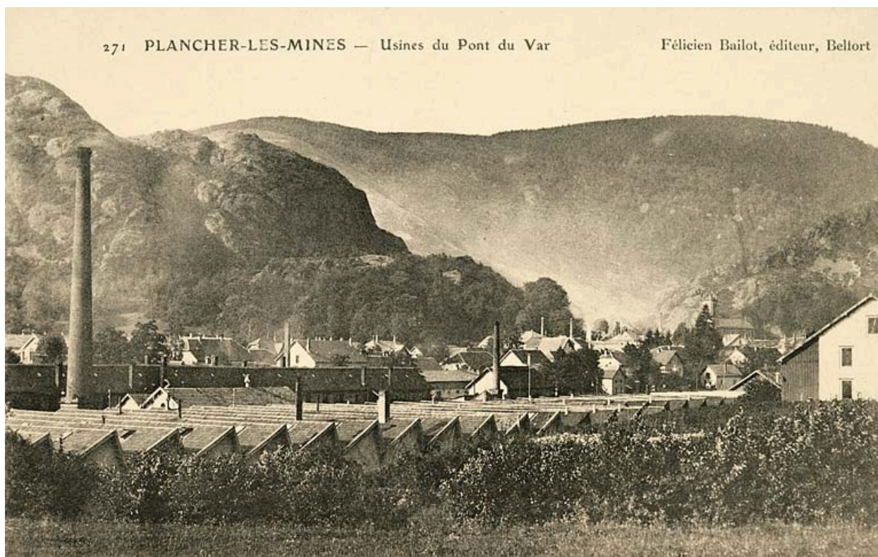
Plancher-les-Mines - Usines de Pont du Var.
