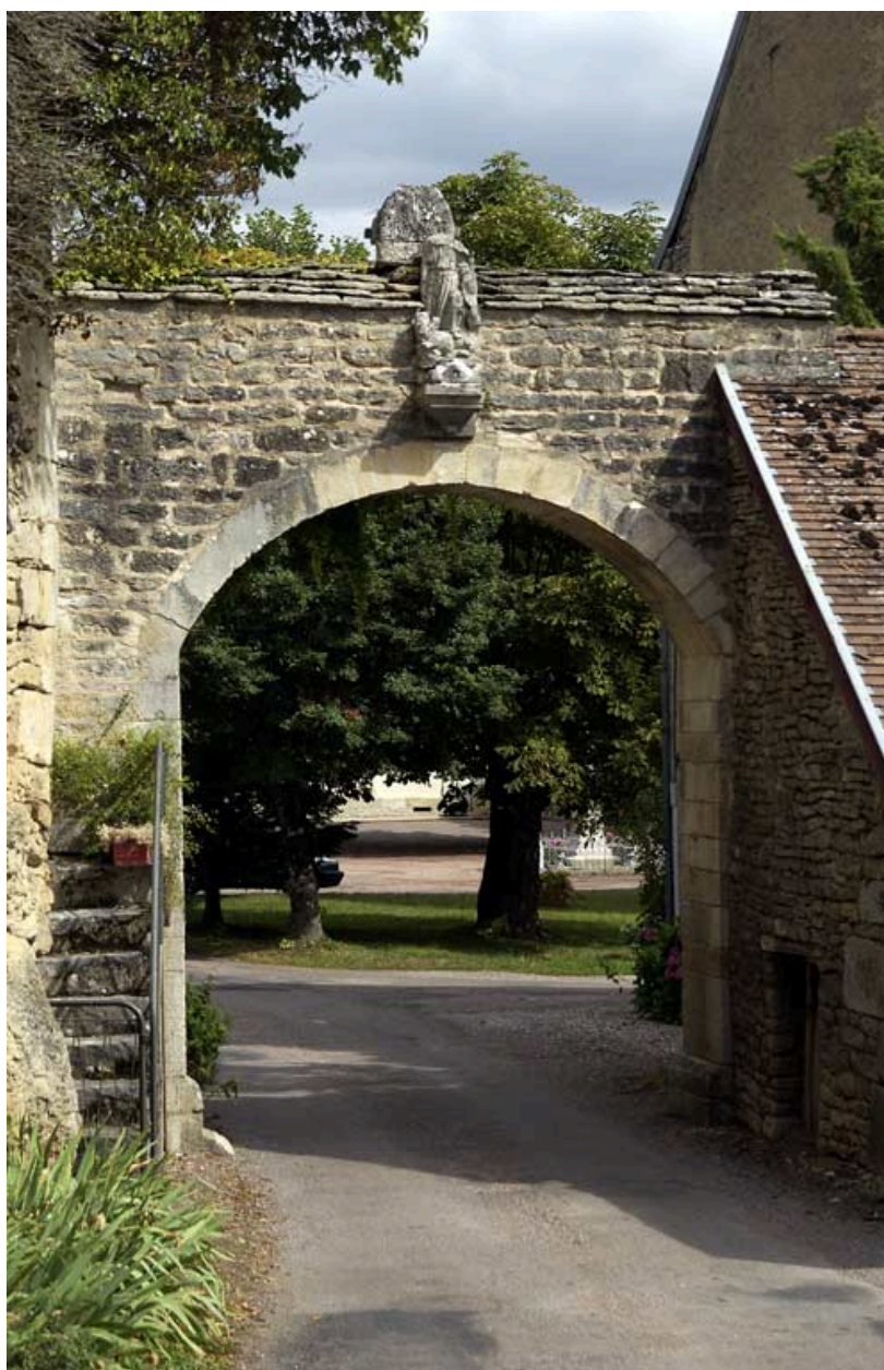
Vestige de la porterie ouest : porte cochère (face ouest).
