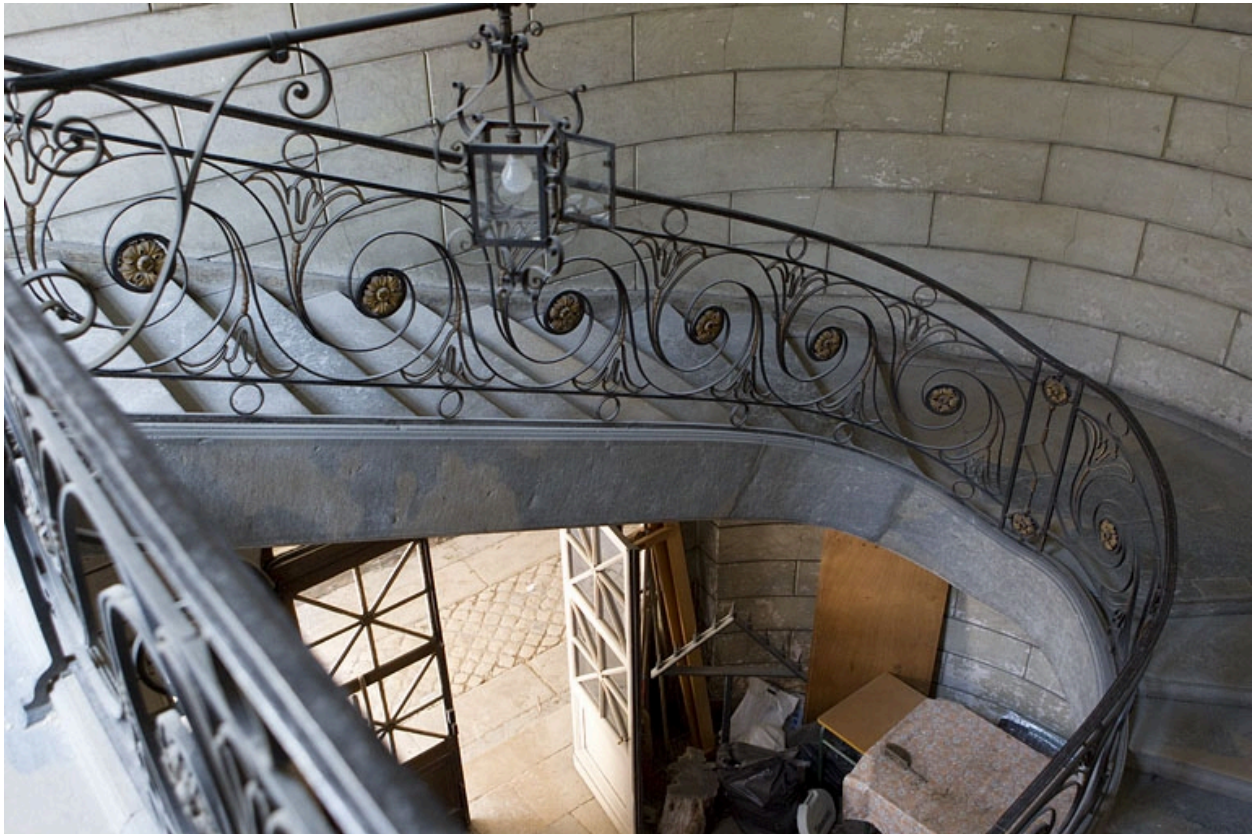
Intérieur : vue d'ensemble de l'escalier.
