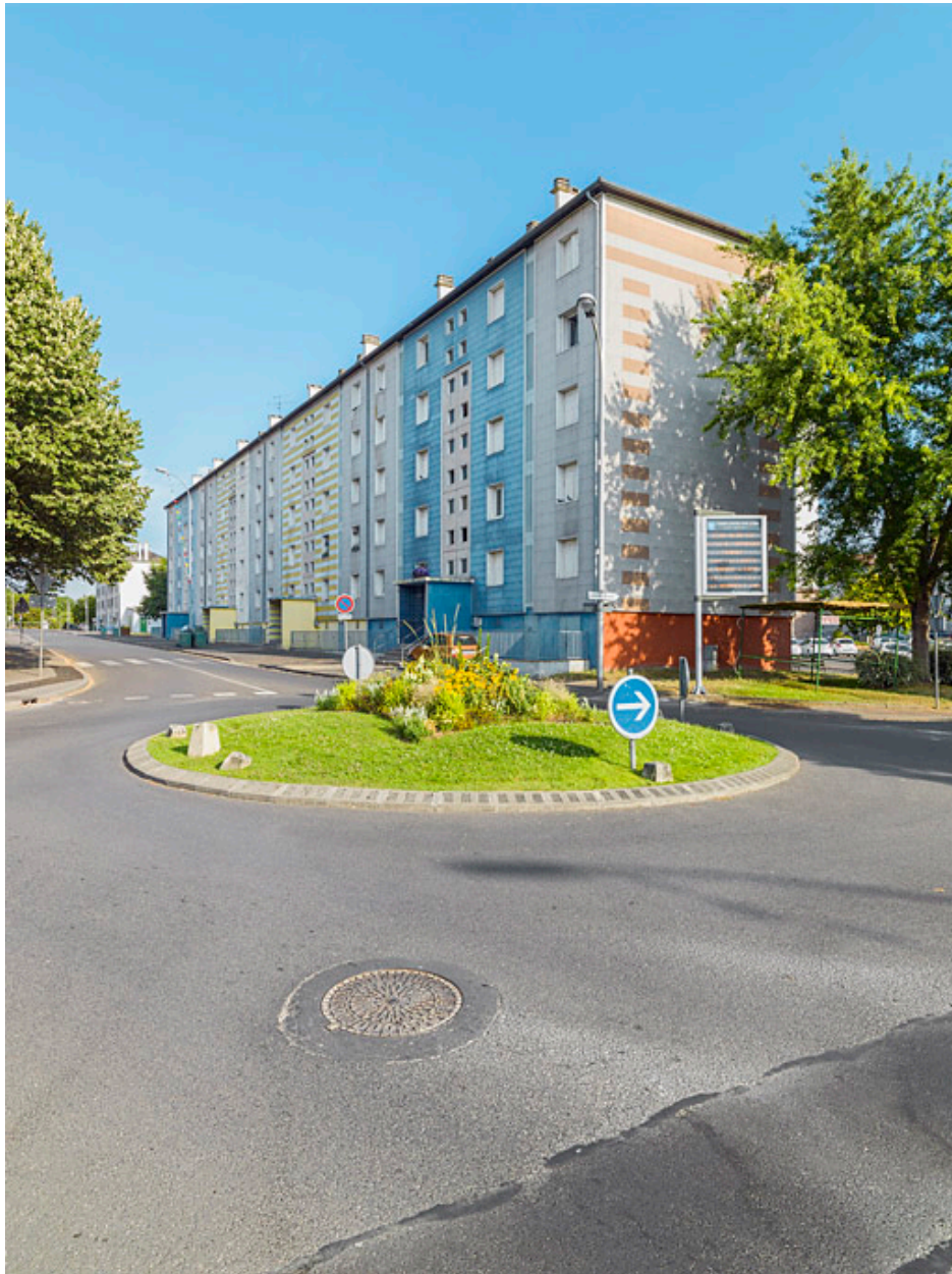
Bâtiment I, façade antérieure.
