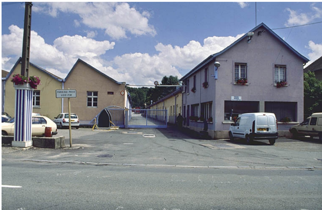
Entrée de l'usine.
