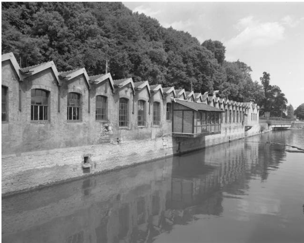
Atelier des fins de séries. Façade est.
