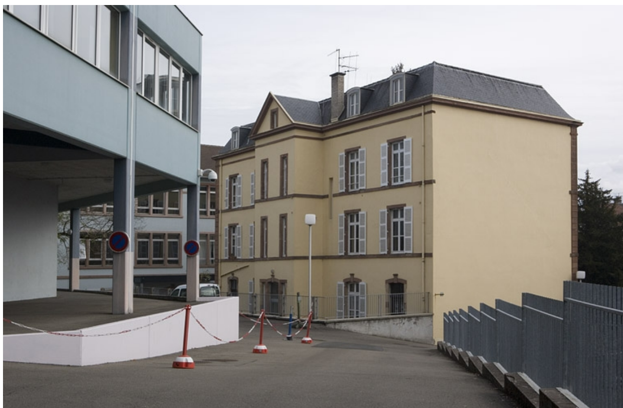
Vue extérieure bâtiment A trois quarts droit.
