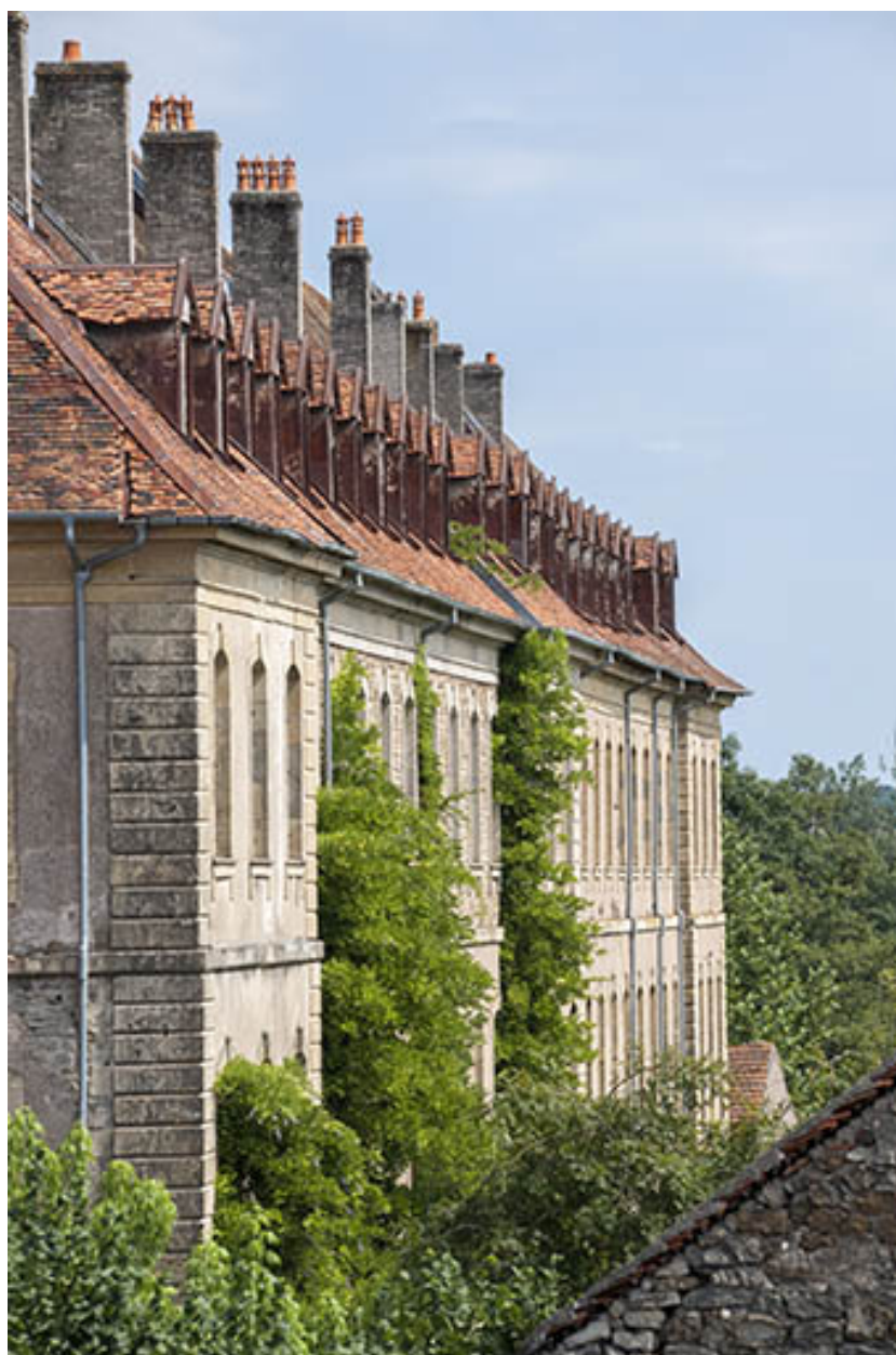
Vue rapprochée de la façade sud.
