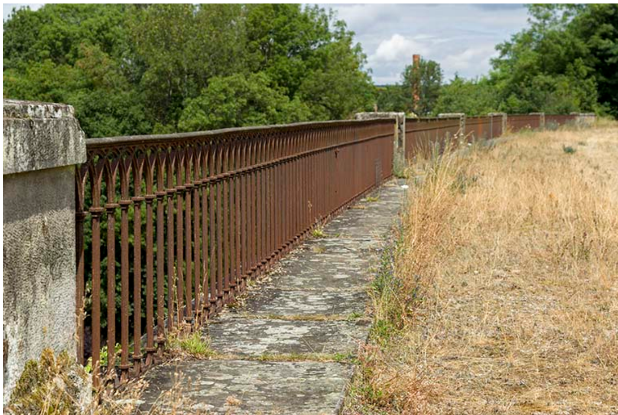
Les garde-corps en fonte.
