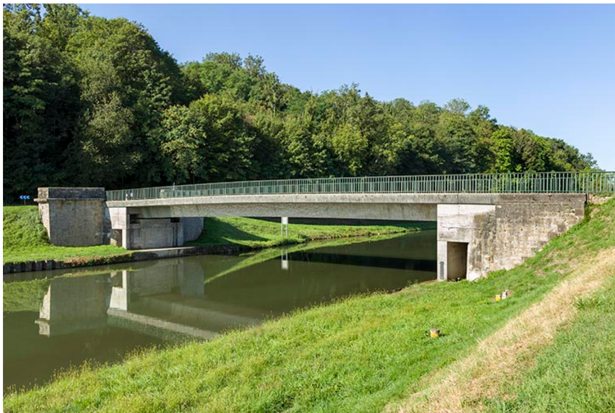
Pont de la D152 enjambant le canal.
