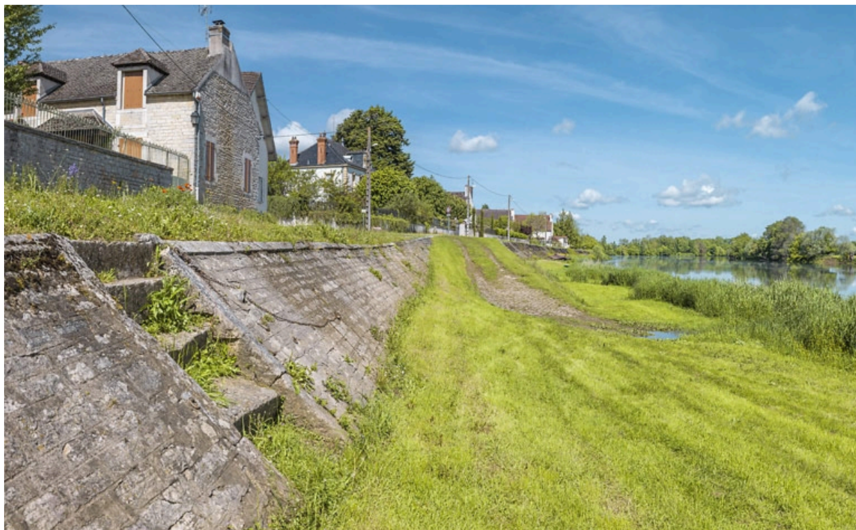
Escalier et rampe de la digue.
