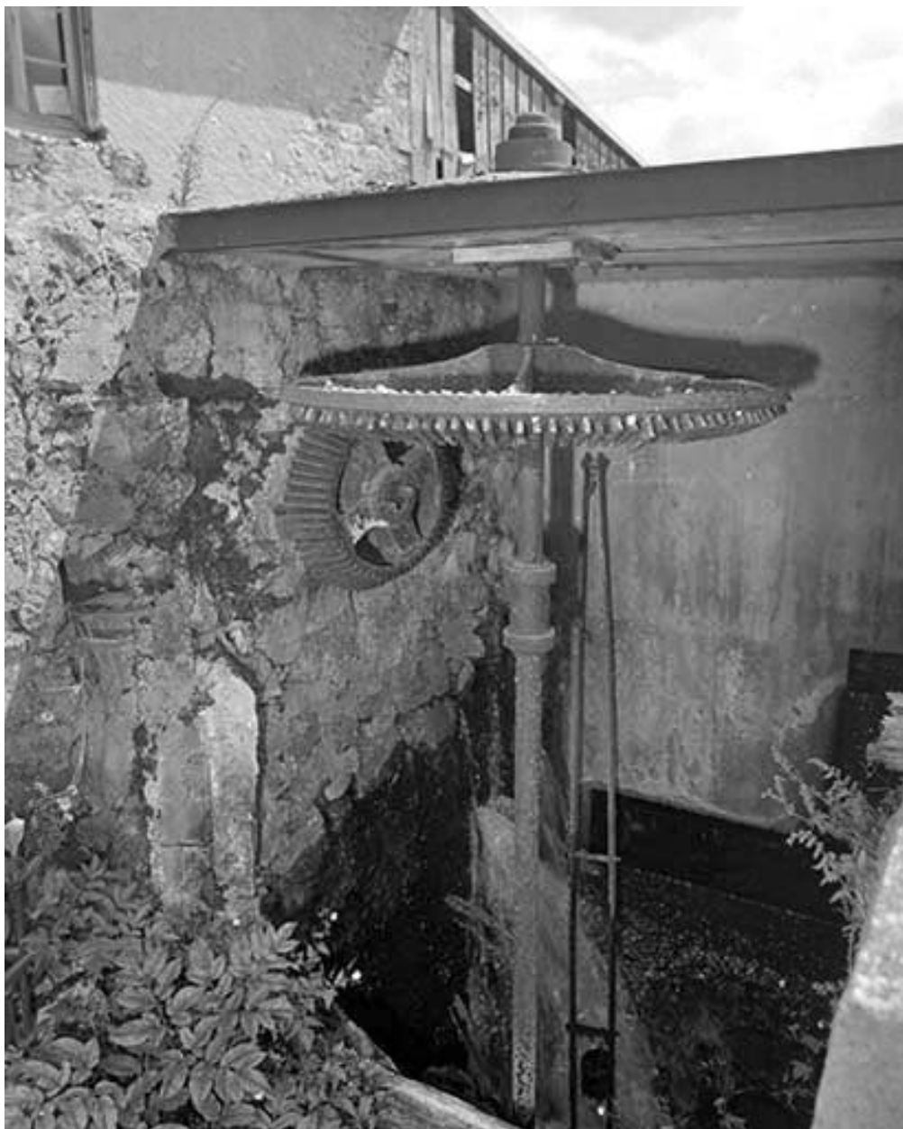
Système de roues hydrauliques, vue rapprochée.
