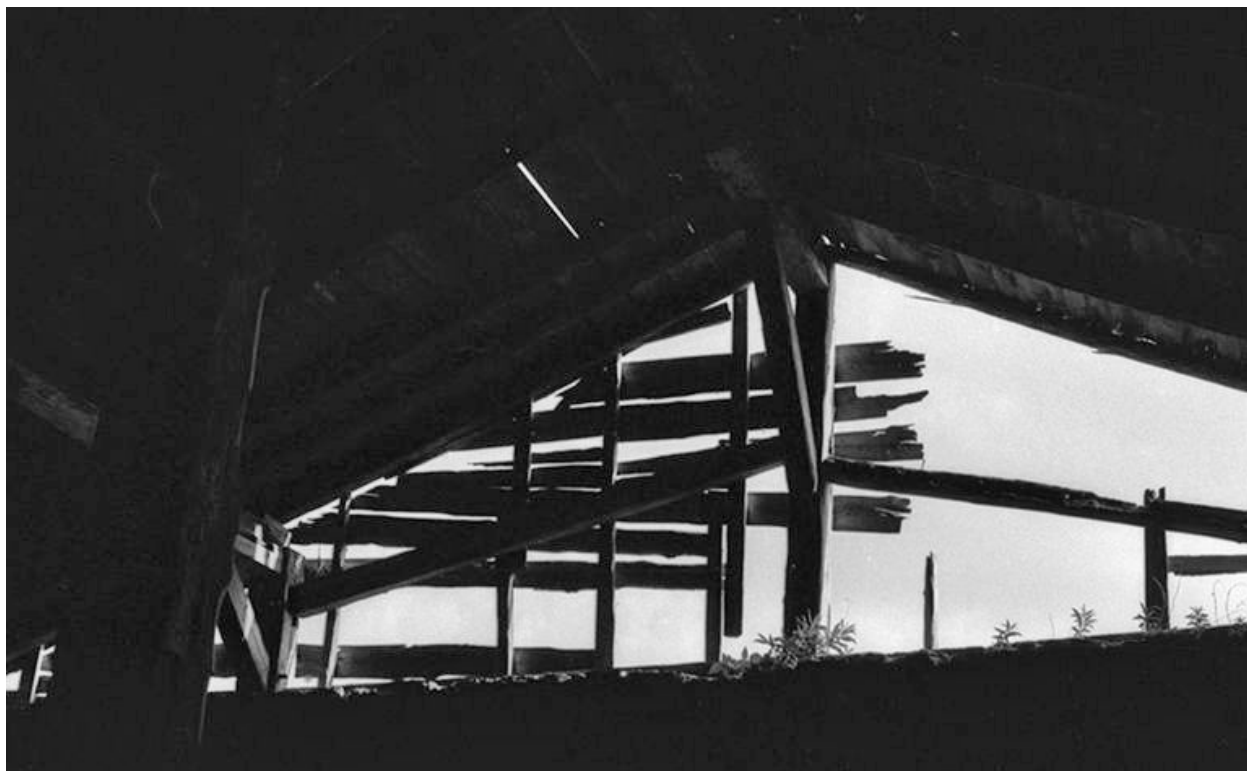
Charpente et "tué".
