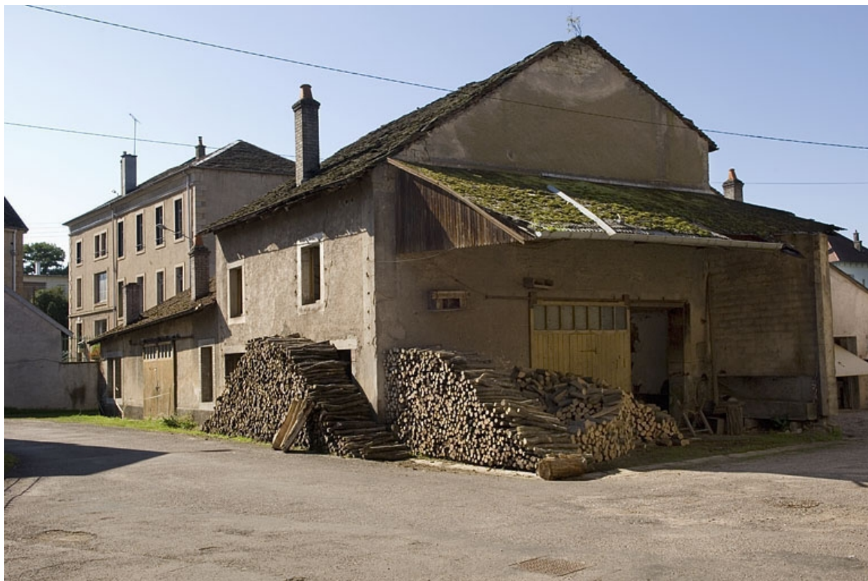
Atelier de fabrication sud.
