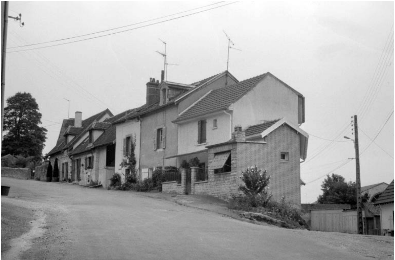
Logements d'ouvriers, depuis le nord.
