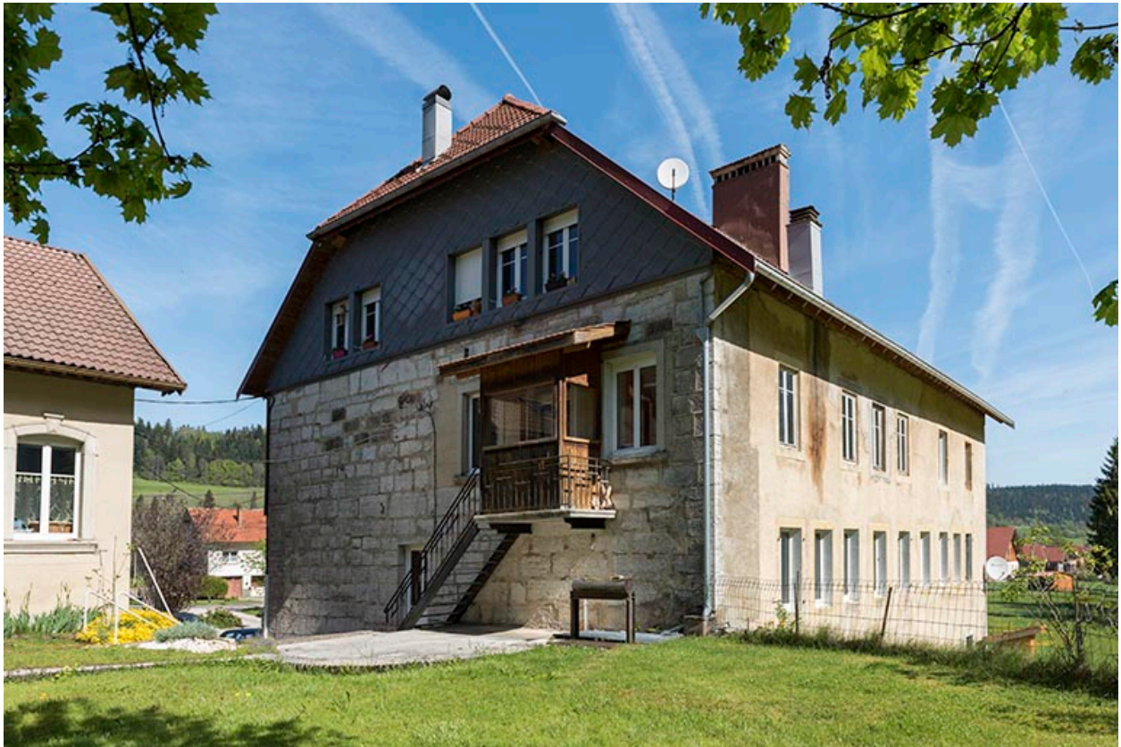
Chaudronnerie : façades postérieure et latérale gauche.
