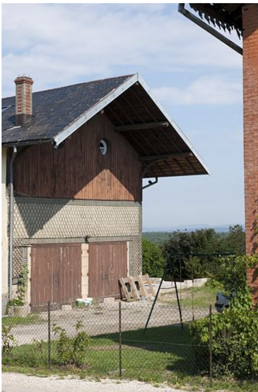
Pignon du bâtiment des remises.
