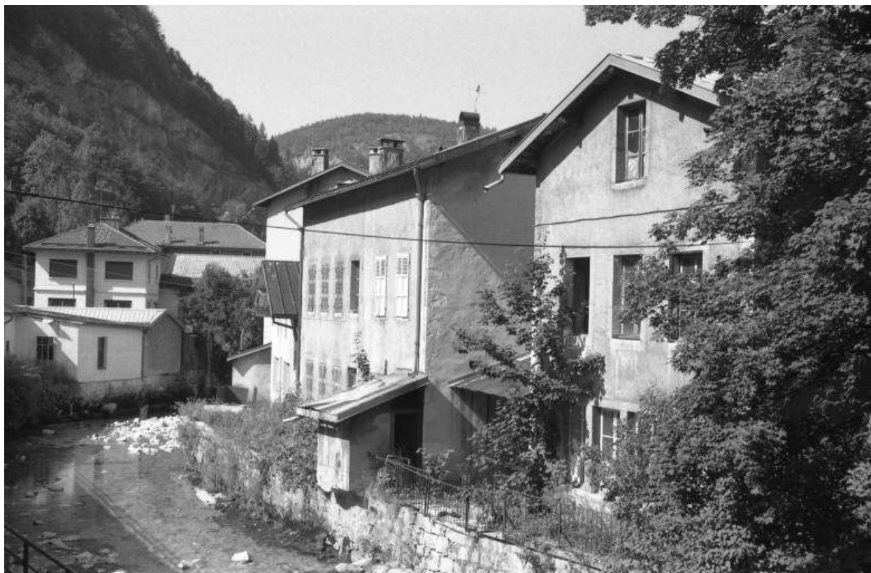
Façade de l'ancienne fonderie, sur la Bienne.
