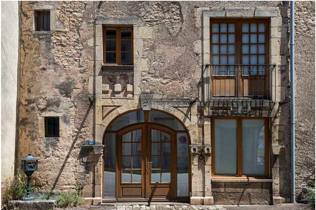
Baies du rez-de-chaussée et du premier étage.
