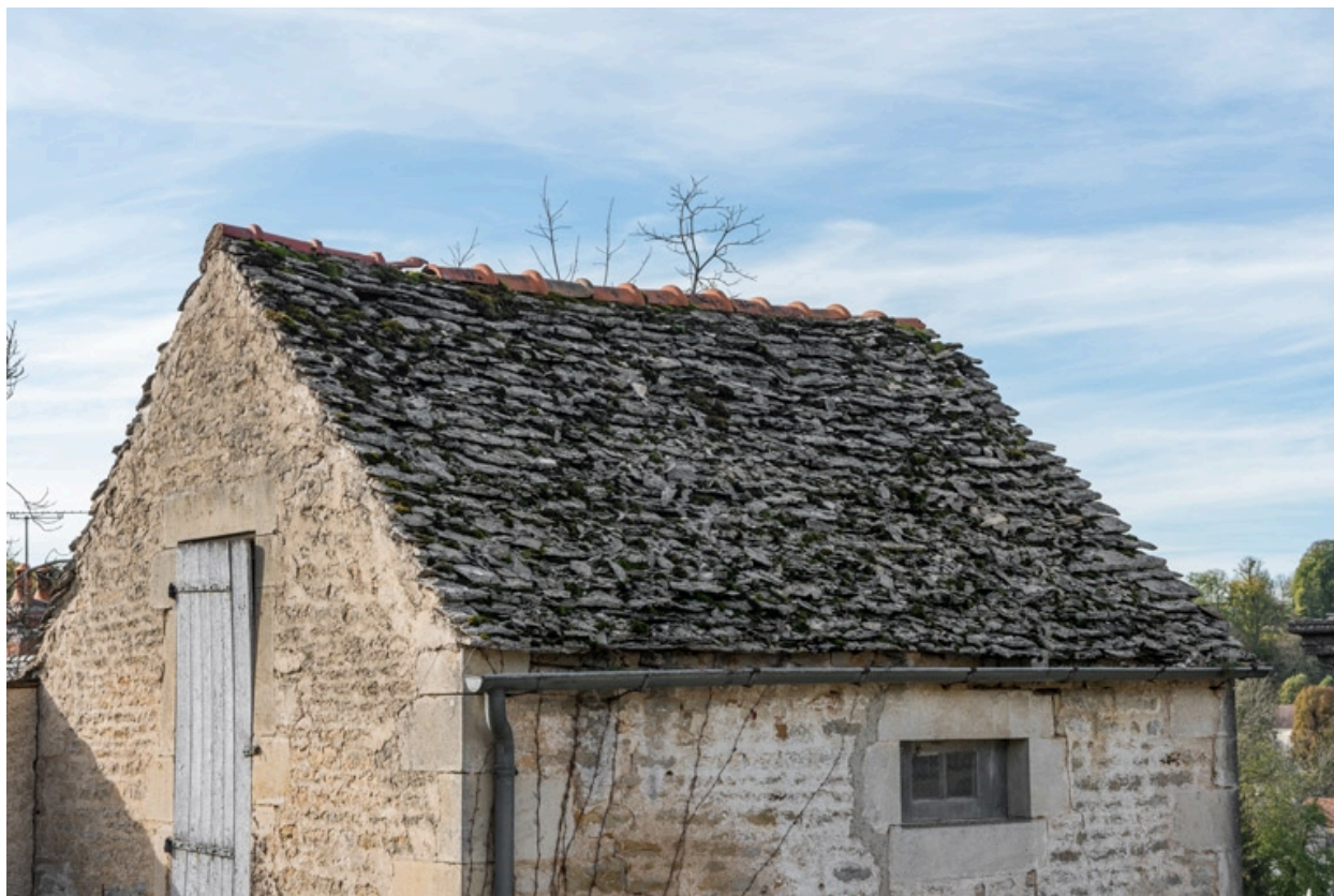
Détail de la toiture.
