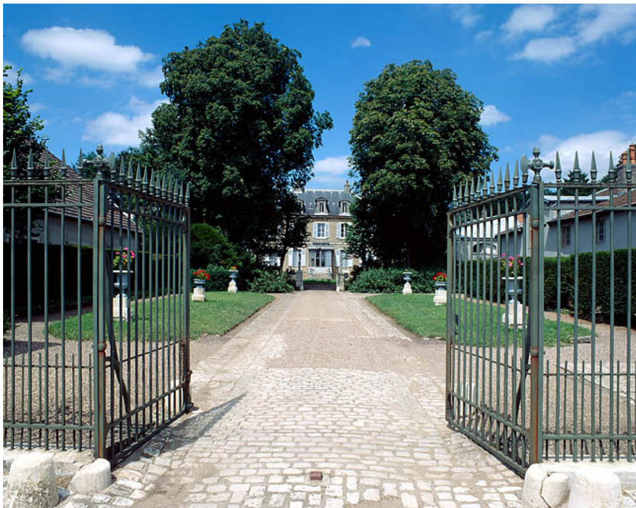
Bâtiment d'habitation depuis la grille d'entrée ouverte.
