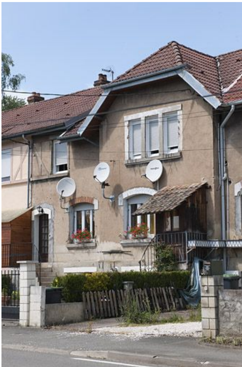
Logement ouvrier P. Détail de la façade.
