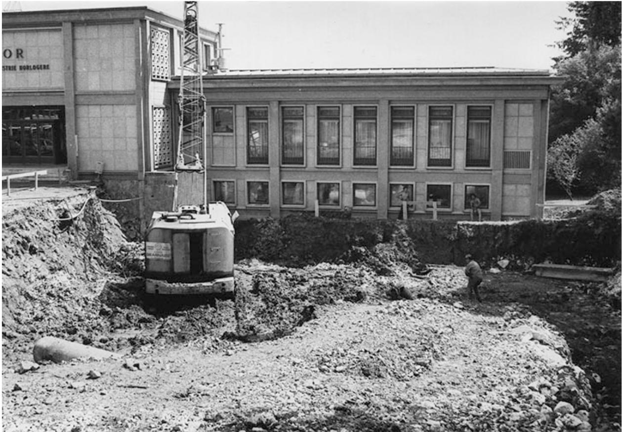
[Construction du laboratoire de métrologie, fondations : battage des pieux], 1981.
