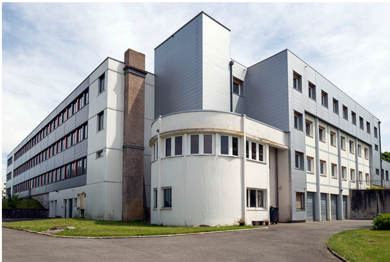
Bethoncourt, site Camus du lycée des Huisselets : externat et cafétéria.
