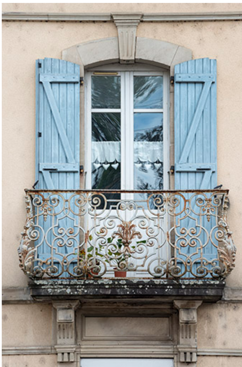
Le balcon, travée centrale.
