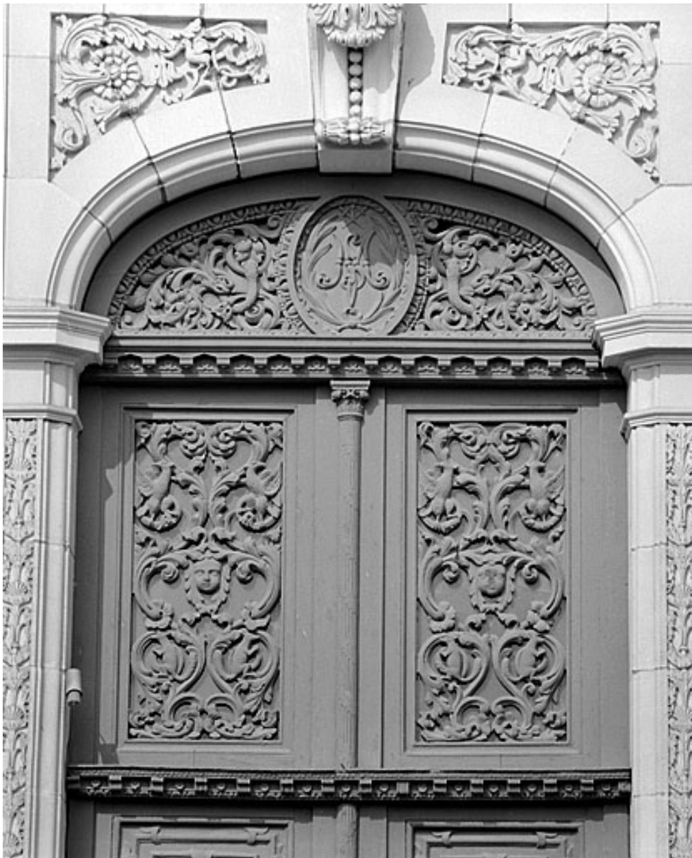
Façade principale, détail de la menuiserie de la porte de droite.
