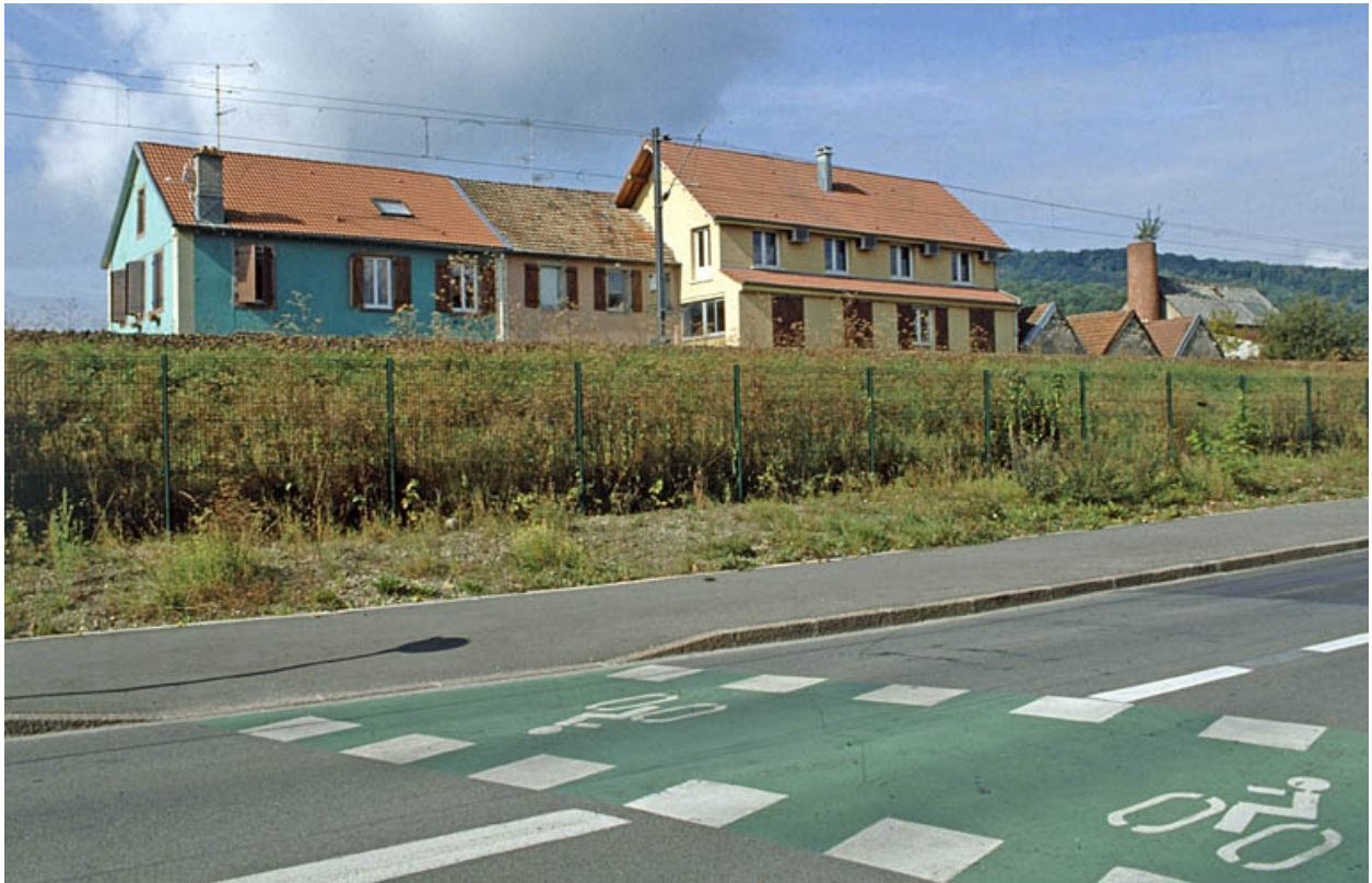
Logements et ateliers depuis le sud-est.
