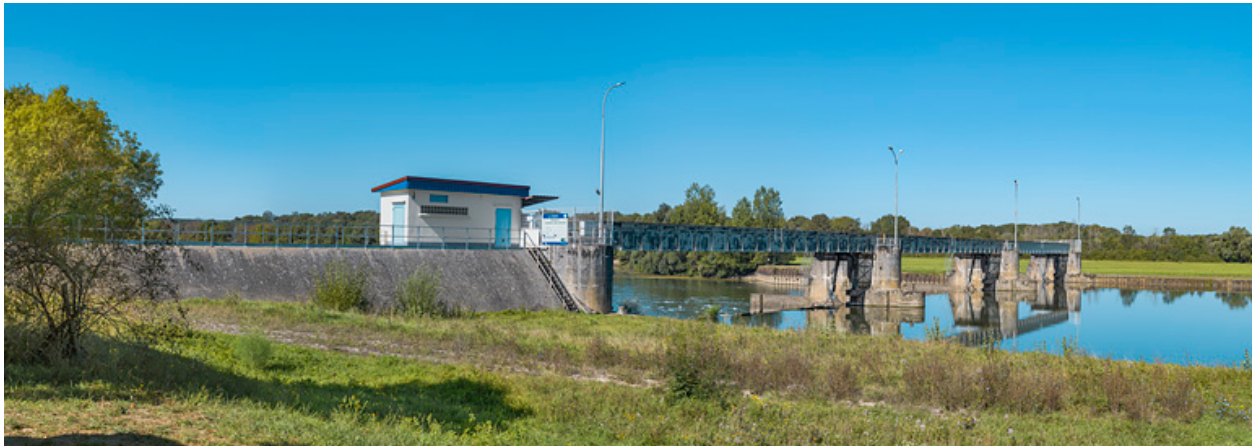
Vue d'ensemble d'amont depuis Charnay-lès-Chalon, rive gauche.
