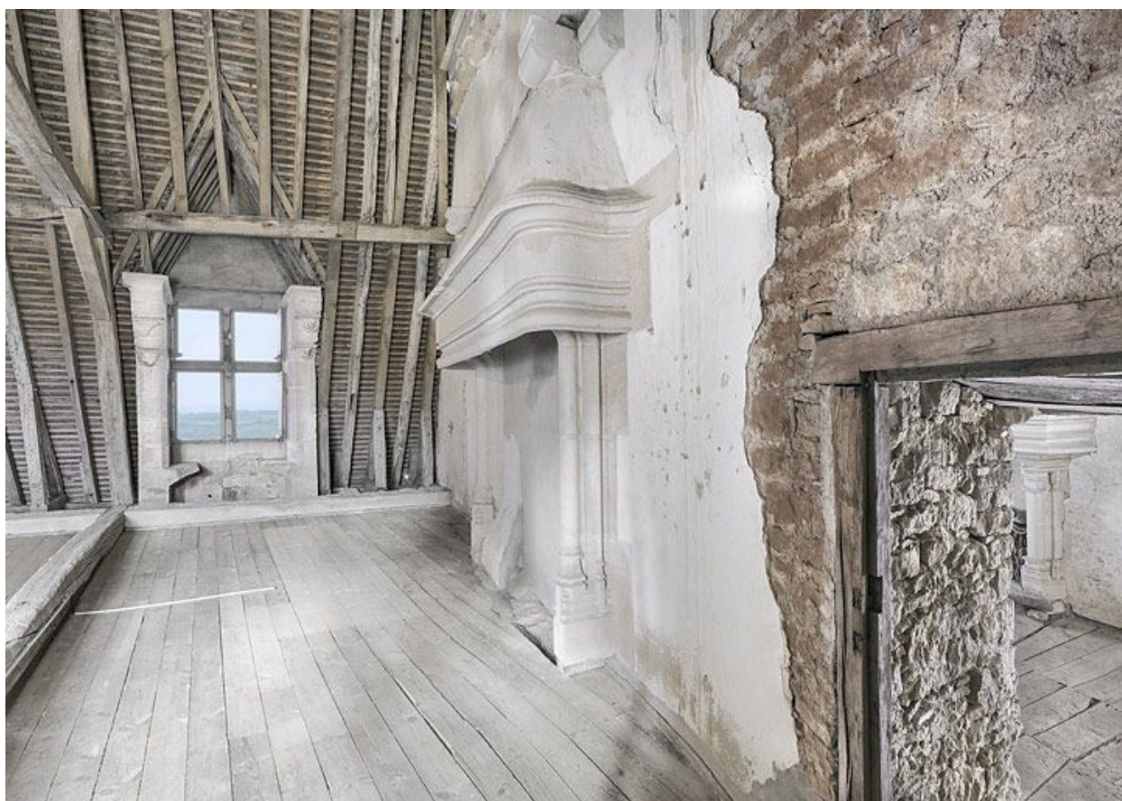
Combles : au-dessus du grand logis, partie droite. Mur de séparation avec la tour carrée. Cheminée et fenêtre à montants sculptés.
