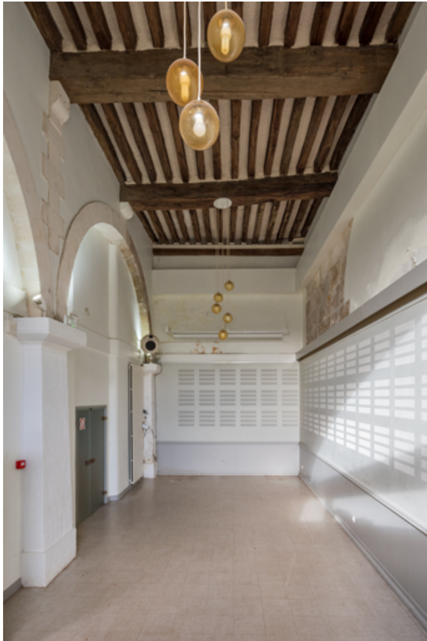
Ancienne halle au blé : travée de droite (ayant conservé son plafond de 1828).
