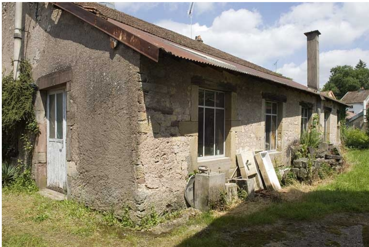
Façade sud de l'ancien moulin.
