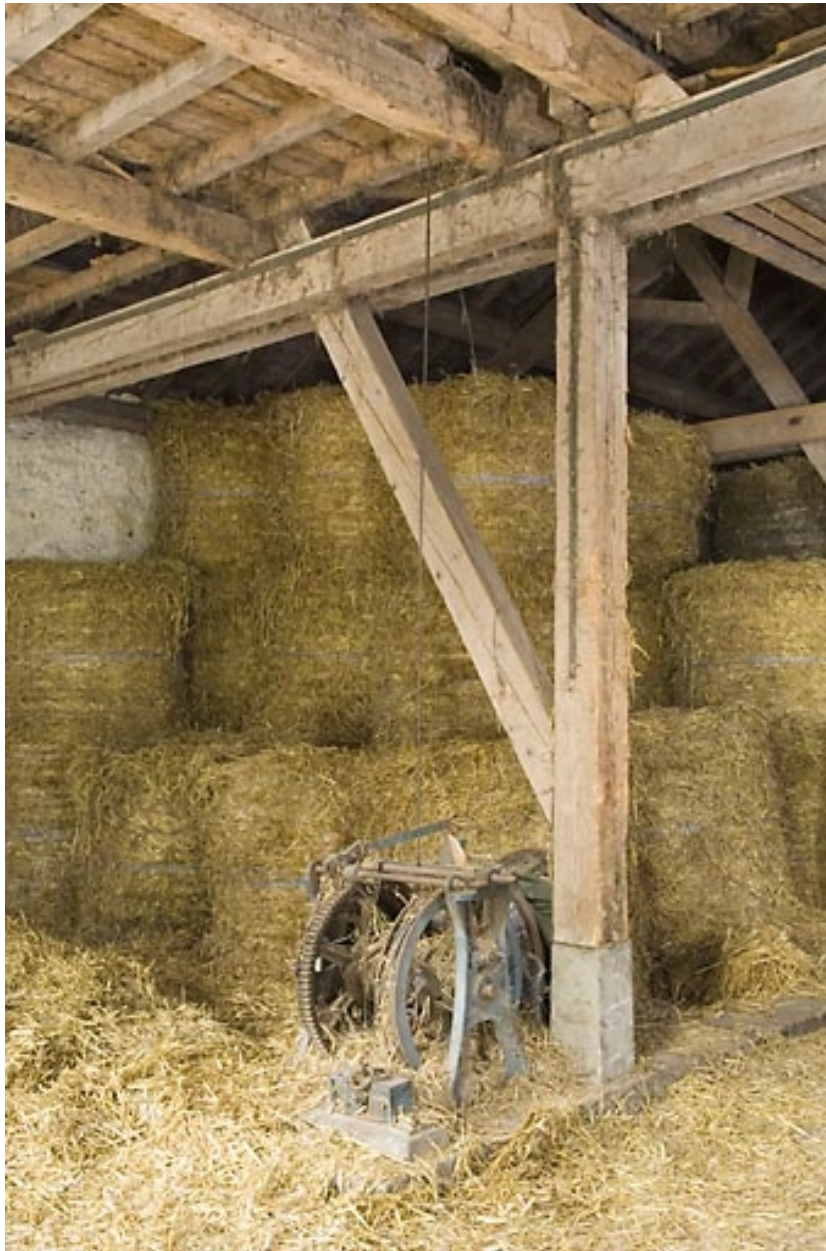
Grange haute : vue d'ensemble du treuil de la déchargeuse.
