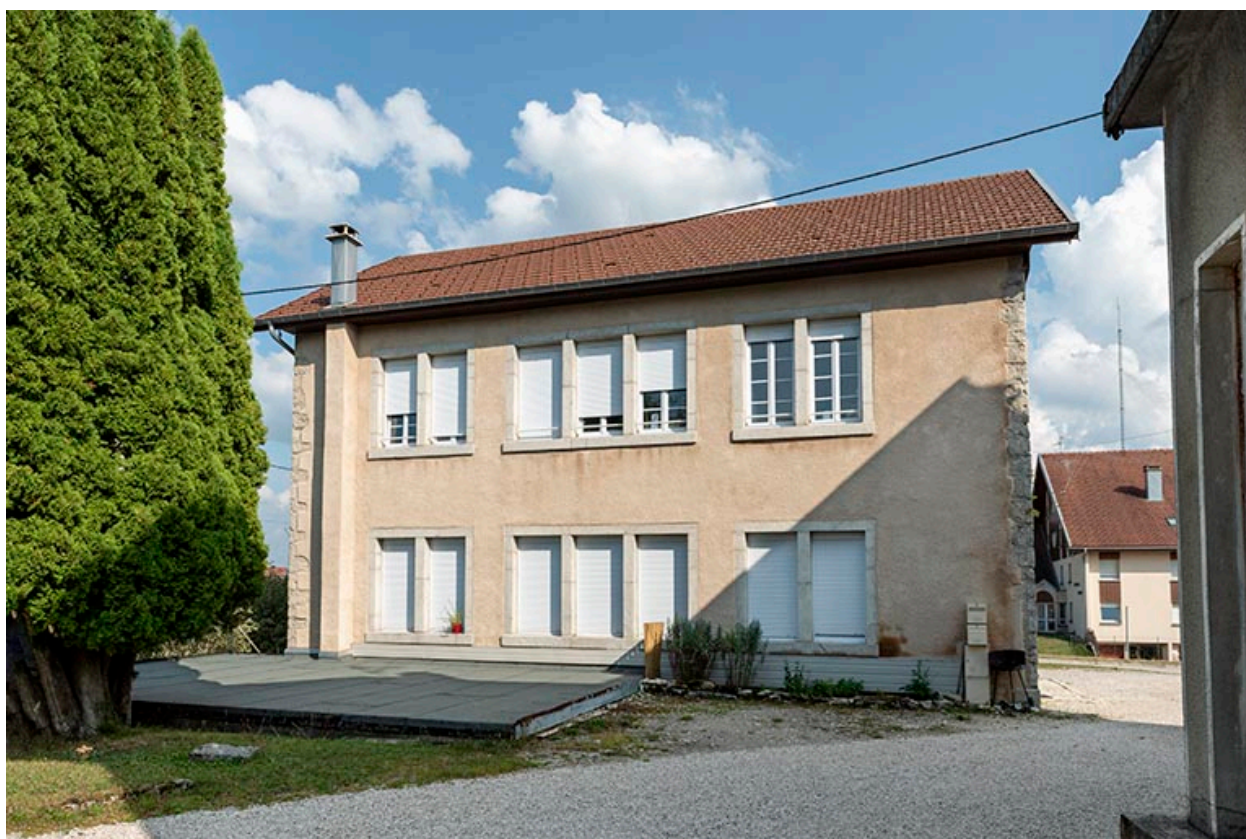
Atelier de fabrication : façade ouest.
