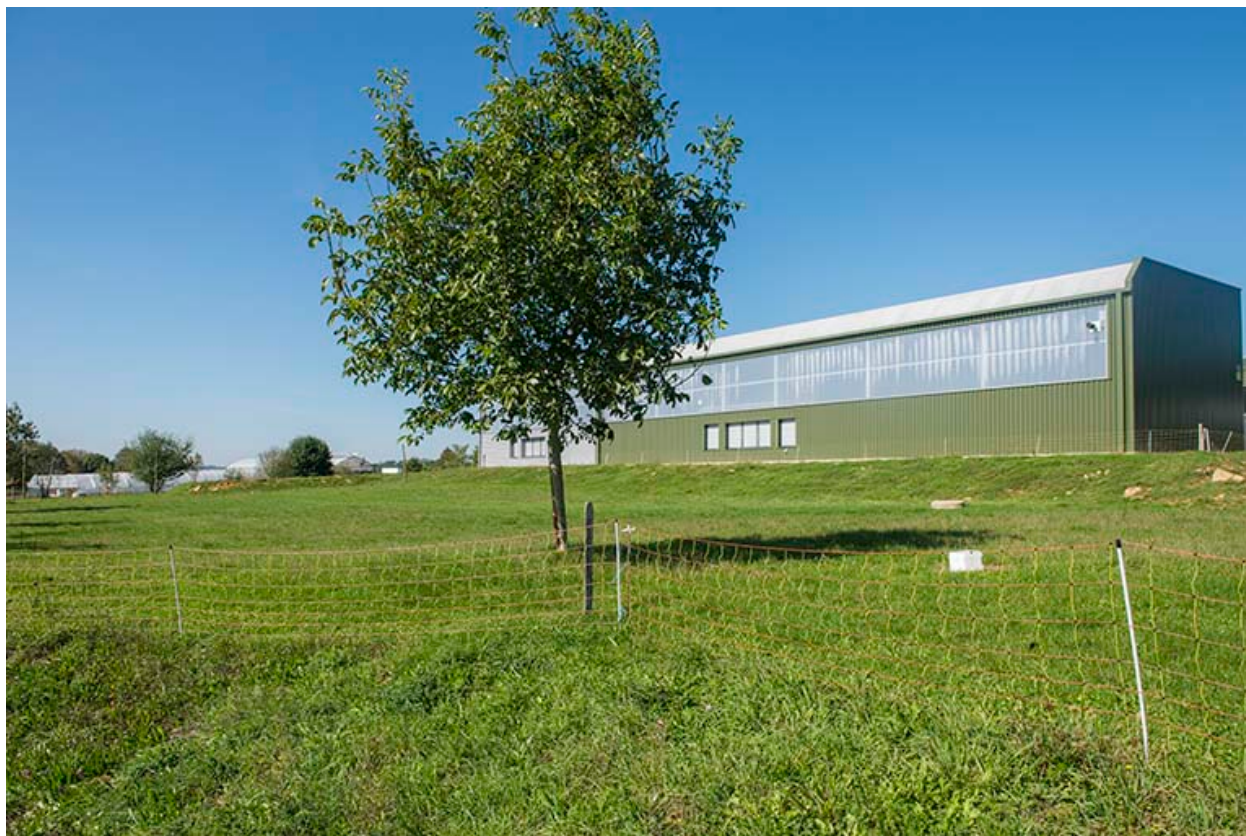
Façade sud de la halle du machinisme.
