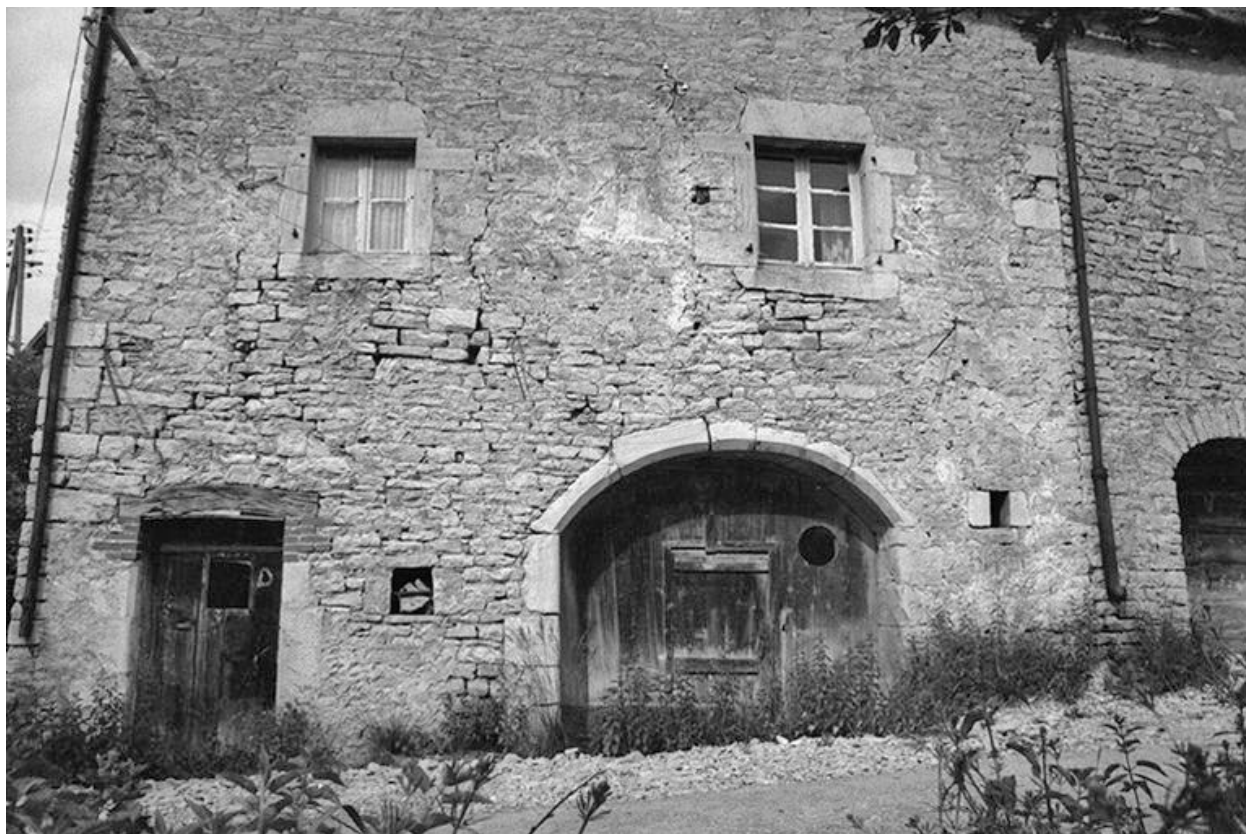
Ferme cadastrée 1960 B 106-107, située au lieudit La Peyrouse : façade antérieure.
