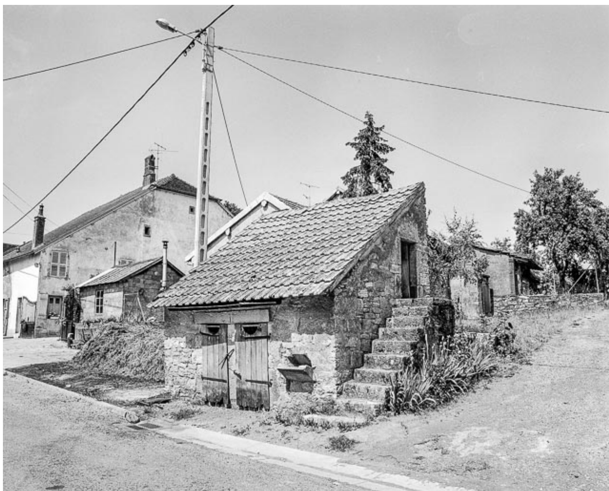
Maison située rue d'Amont à Chenevrey : la porcherie.
