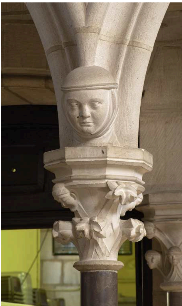
Bâtiment du réfectoire : réfectoire néo-gothique, décor sculpté.
