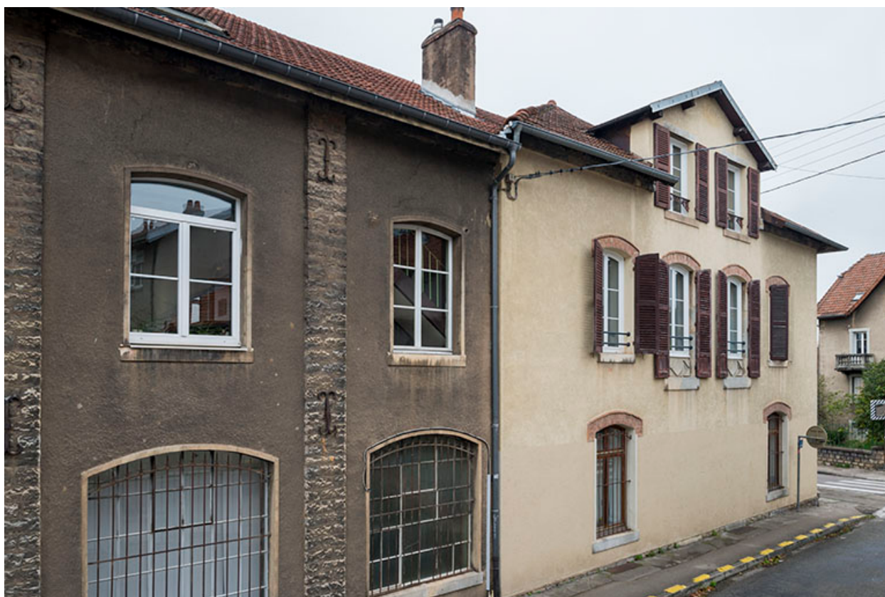
Façade du logement sur la rue Grenier.
