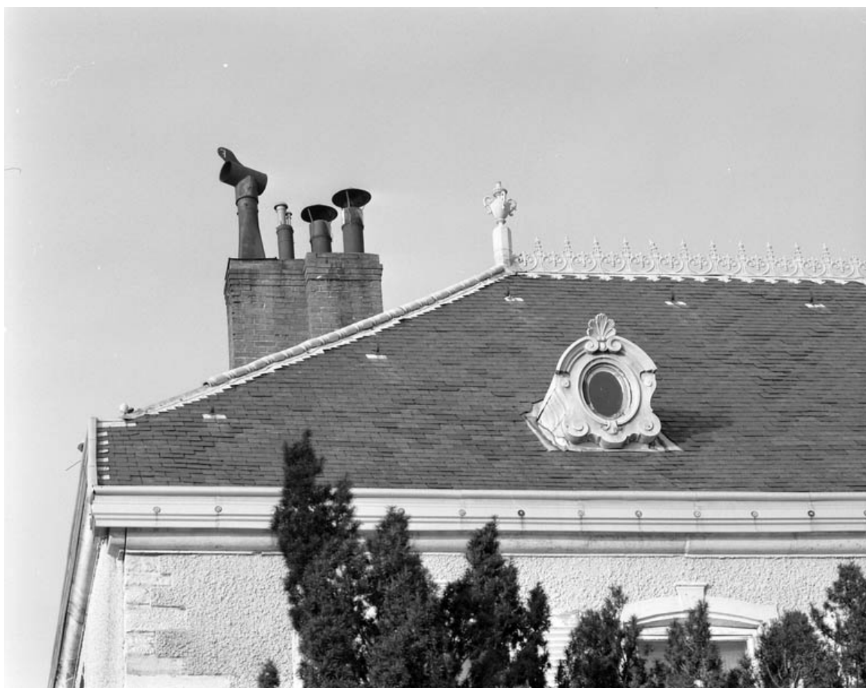
Détail d'une lucarne du toit de l'habitation.
