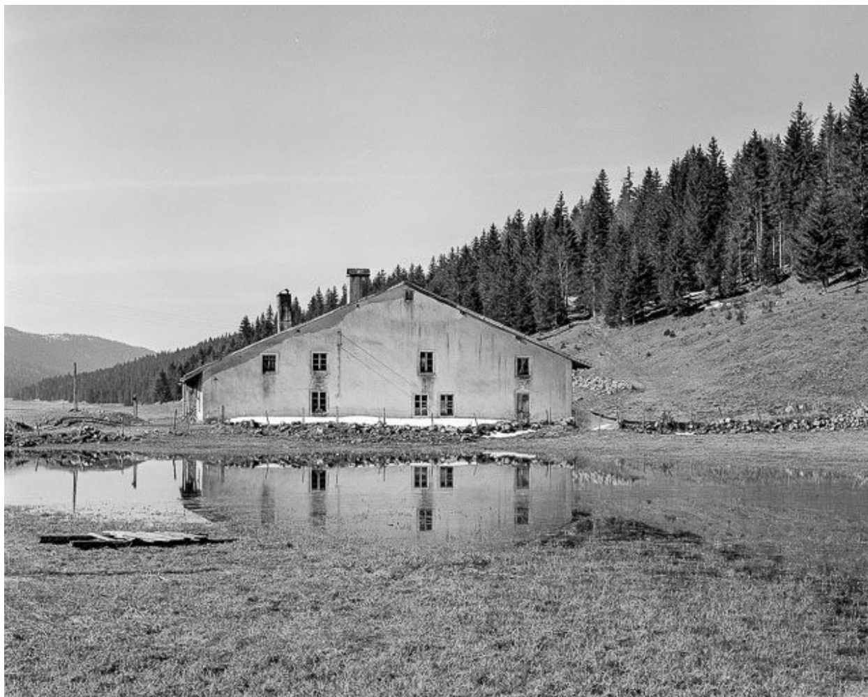
Façade latérale droite.
