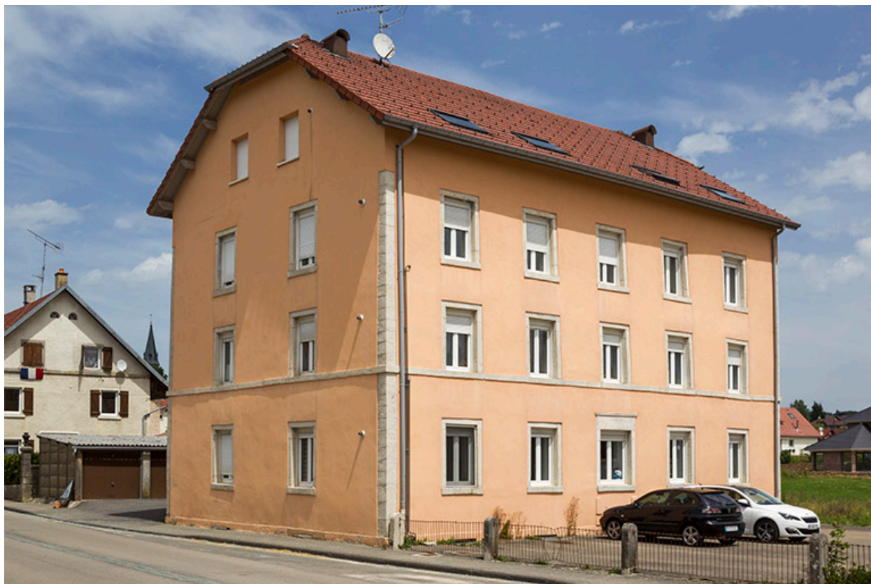
Façades postérieure et latérale droite.
