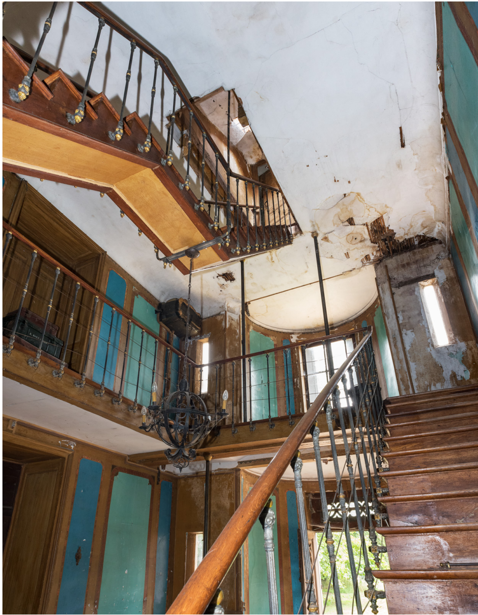
Escalier d'accès à la tourelle (extension nord fin 19e siècle).
