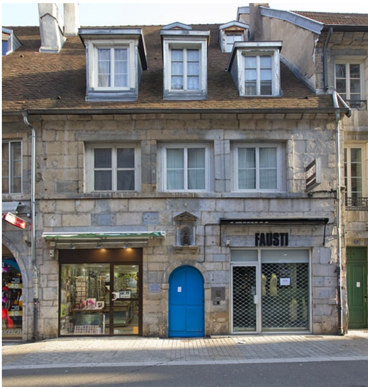
Logis principal, façade antérieure : de face.
