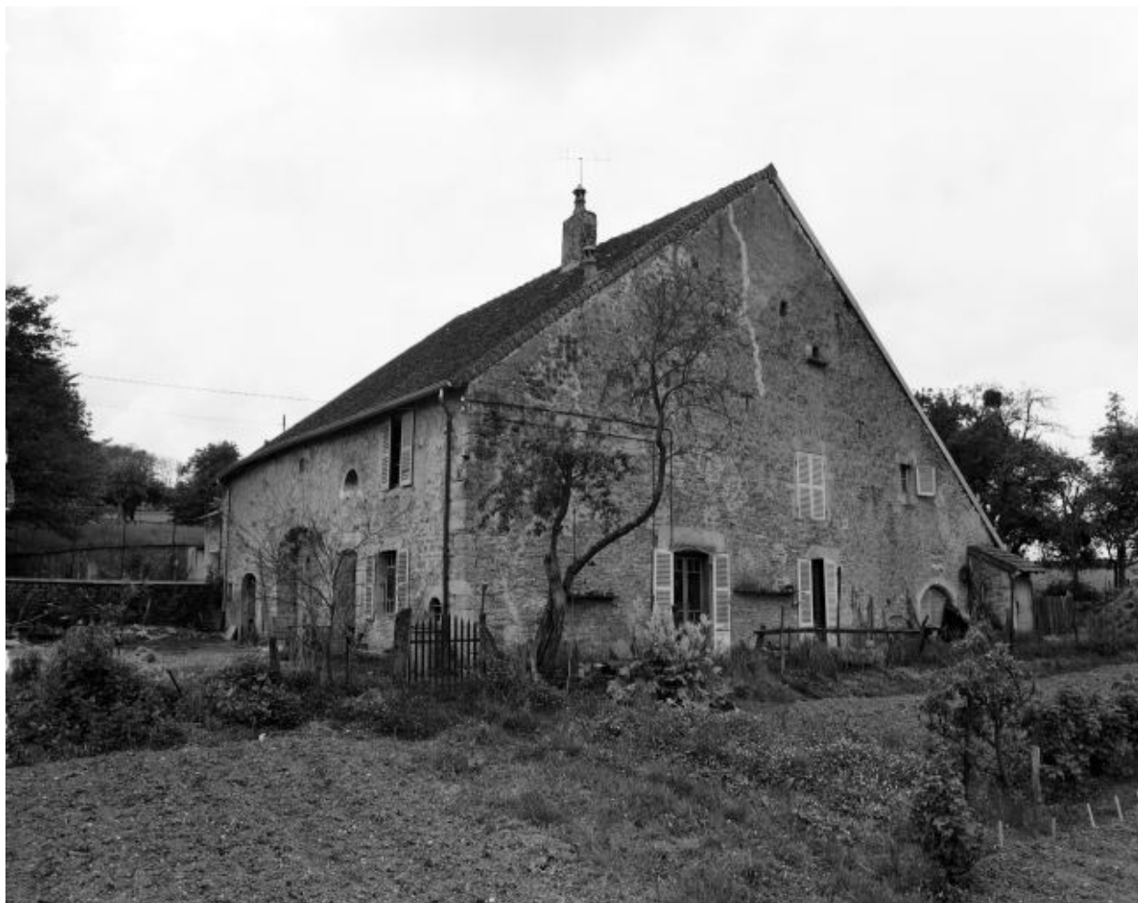
Ferme située rue du Quart d'Avaud.
