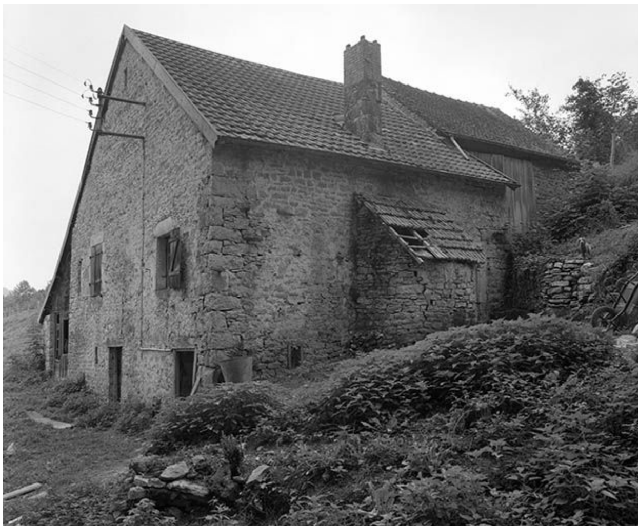
Façade antérieure et face latérale droite.
