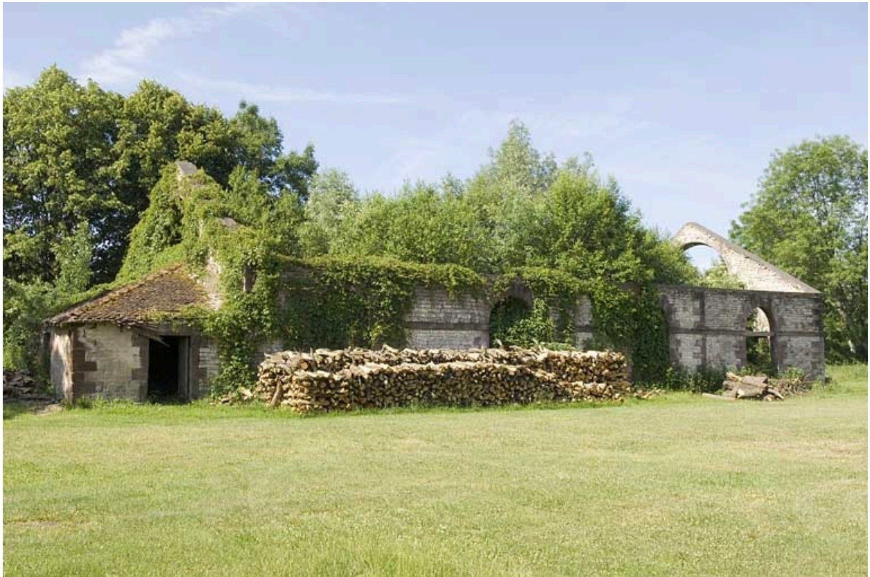
Atelier du laminoir (en ruines). Vue de trois quarts gauche.
