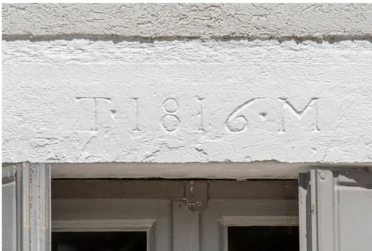
Ancienne ferme, façade antérieure : linteau daté 1816.
