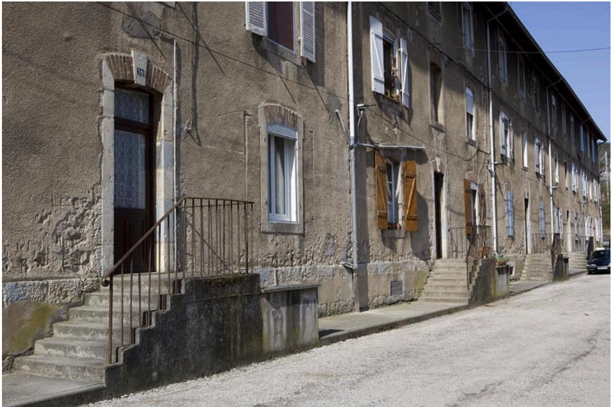
Logement d'ouvriers (10 à 16 rue des Ecoles). Détail des entrées sur la façade nord.
