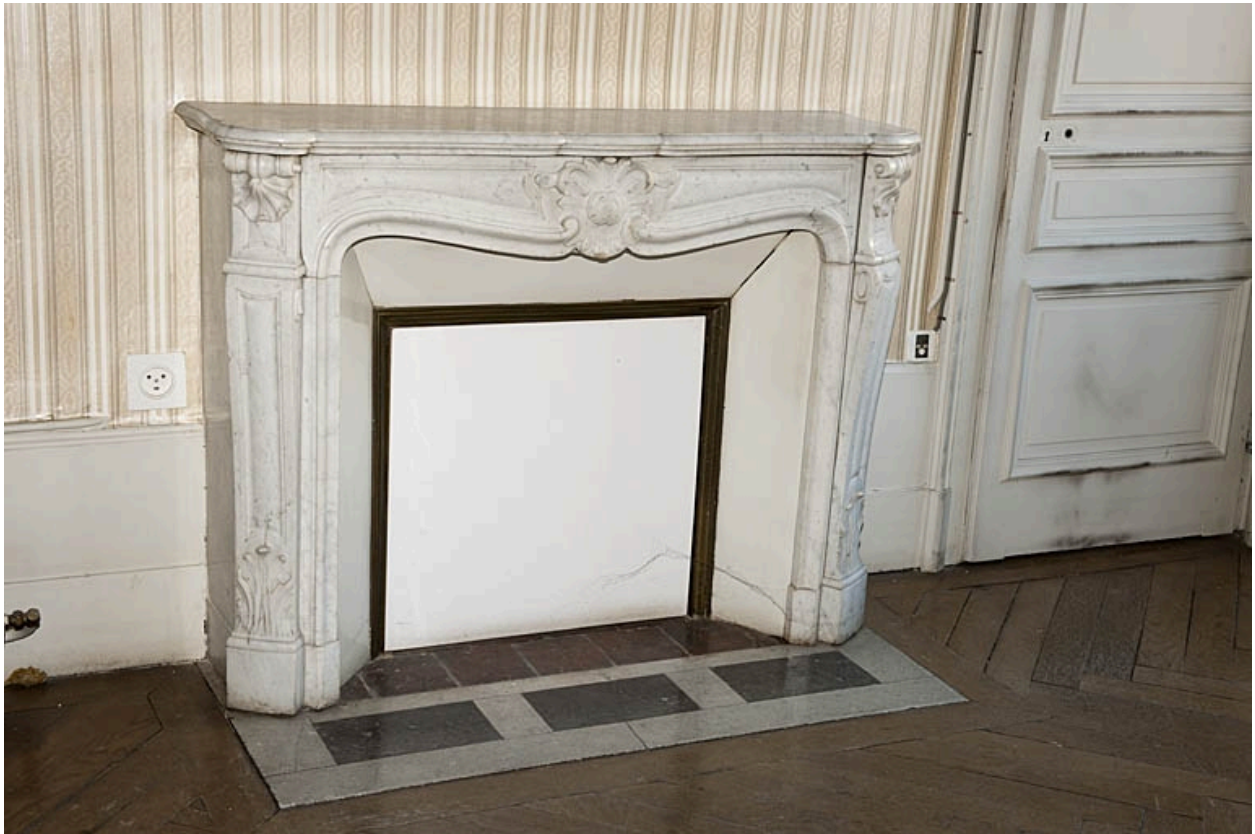
Logis au fond de la deuxième cour : détail d'une cheminée d'une pièce de l'étage.
